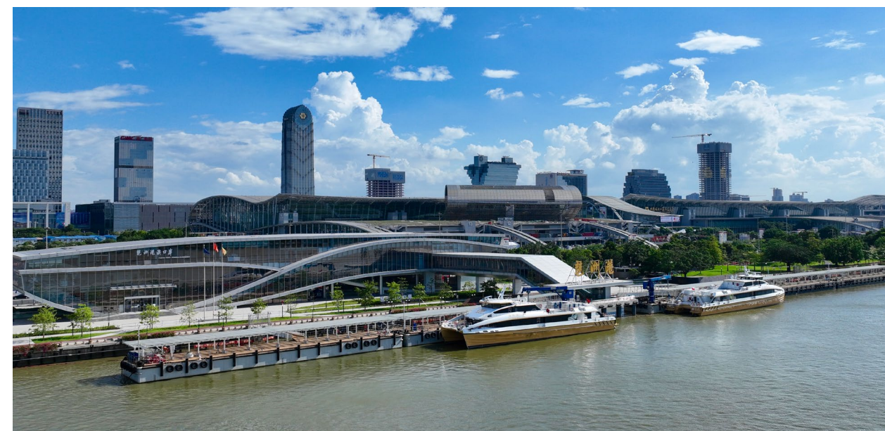
2025 年 12 月，琶洲港澳客运码头顺利通过国家口岸管理办公室验收，标志着该码头全面正式对外开放，为推动大湾区港口群协同发展、深化基础设施“硬联通”与规则机制“软联通”提供重要支撑
