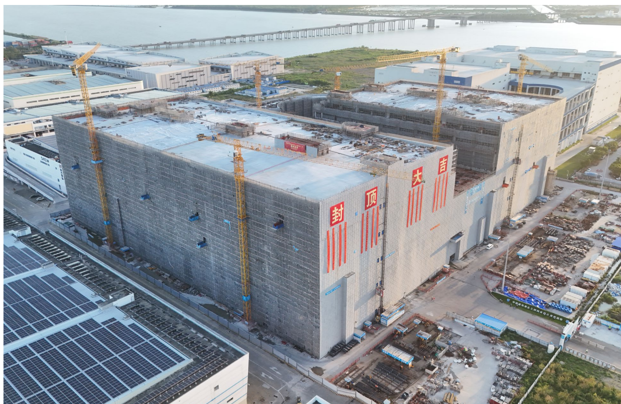
2025 年 10 月，珠江船务省重点项目粤港澳大湾区国际分拨中心（9 号物流仓库）一期项目主体顺利封顶。建成后，将为南沙综保区新增一座五层盘道式高标准综合物流仓库，持续赋能南沙国际航运中心建设
